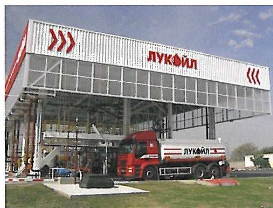
Terminál pro výdej pohonných hmot do autocisteren společnosti Lukoil v bulharském Plovdivu byl uveden do provozu v září 2007 jako stavba „na klíč“. Jeho součástí je i systém pro aditivaci pohonných hmot „EVA“ z vývojářského centra VAE CONTROLS, Tank trucks loading terminal of company Lukoil in Plovdiv (Bulgaria) was put in service in September 2007 as a „turn-key“ delivery. It includes also fuel addition system „EVA“ developed and produced by VAE CONTROLS
